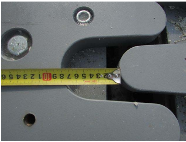
신축 유간거리 측정전경
