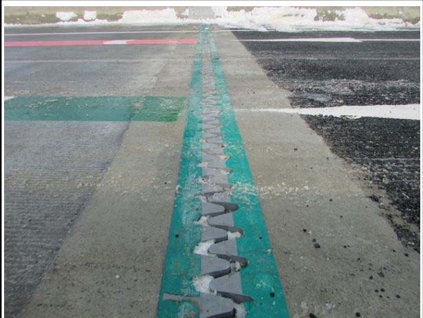
신축이음 상태양호(A2, 옥산방향)
