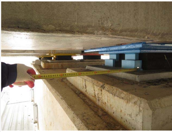
교량받침 연단거리 측정전경
