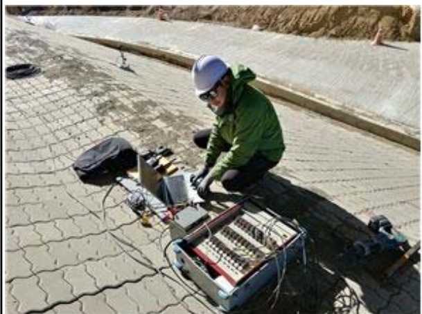
재하시험 계측 전경
