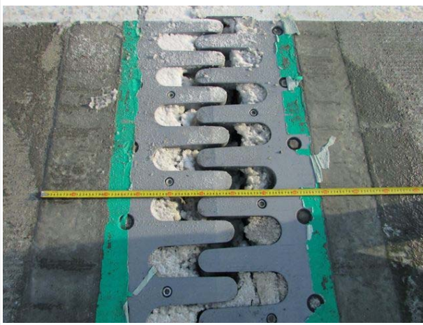
신축 유간거리 측정전경
