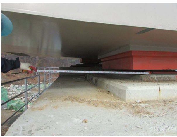
교량받침 연단거리 측정전경
