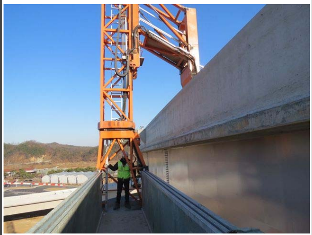
교량점검차를 이용한 바닥판 하부 조사
