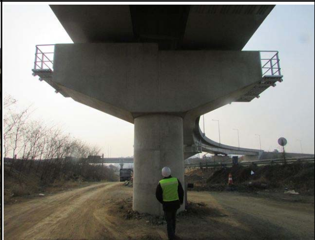
교각 P7 전경(상태양호)
