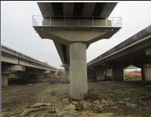
교각 P3 전경(상태양호)
