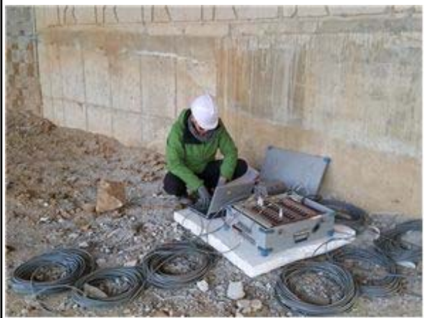
재하시험 계측 전경
