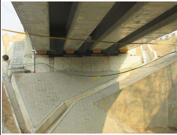
교대 A1 상태양호
