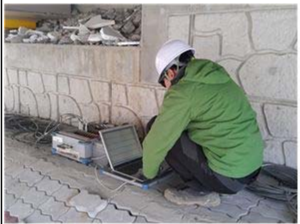
재하시험 계측 전경
