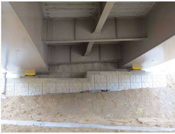
교대 A1 전경
