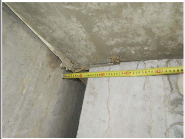
슬래브 유간거리 측정전경
