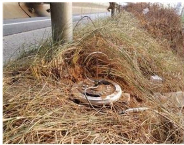
처짐계 설치 현황
