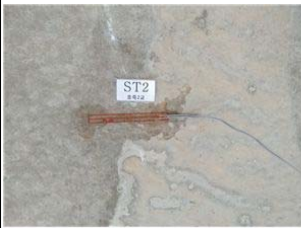
변형률계 설치 현황
