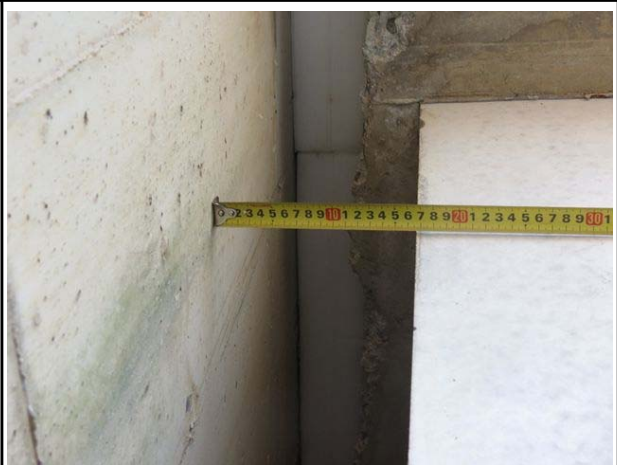
슬래브 유간거리 측정전경
