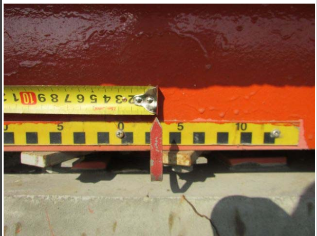
교량받침 이동량 측정전경
