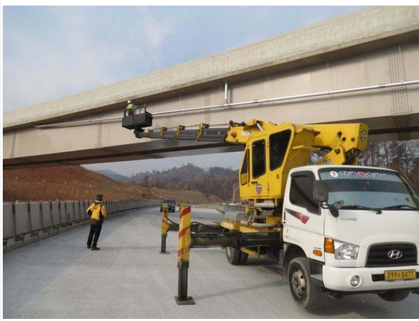
고소 점검차를 이용한 바닥판 하부 조사
