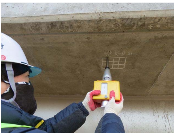
반발경도측정 시험 전경
