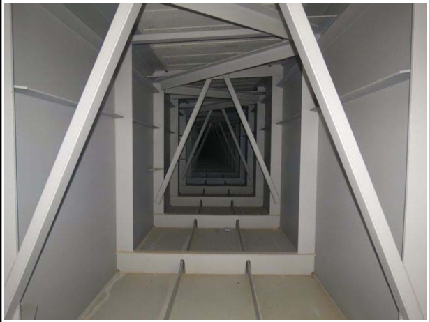
강제 거더 내부 상태양호
