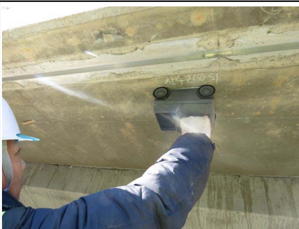
철근배근탐사 시험 전경
