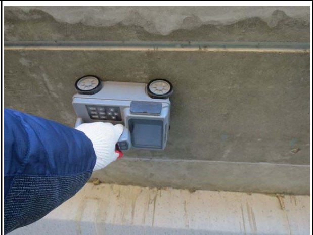
철근배근탐사 시험 전경
