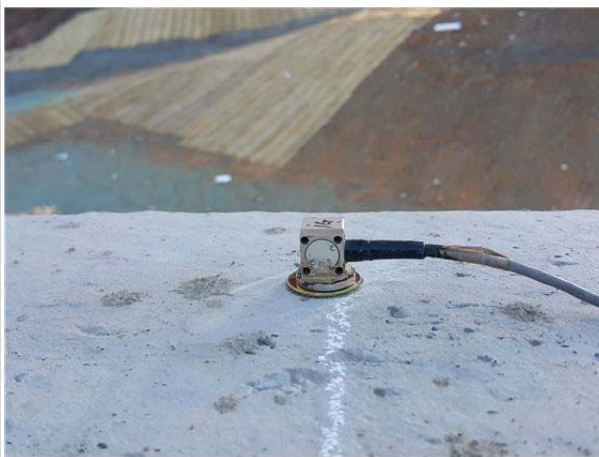
가속도계 설치 현황
