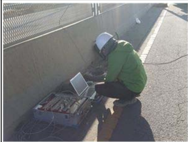
재하시험 계측 전경
