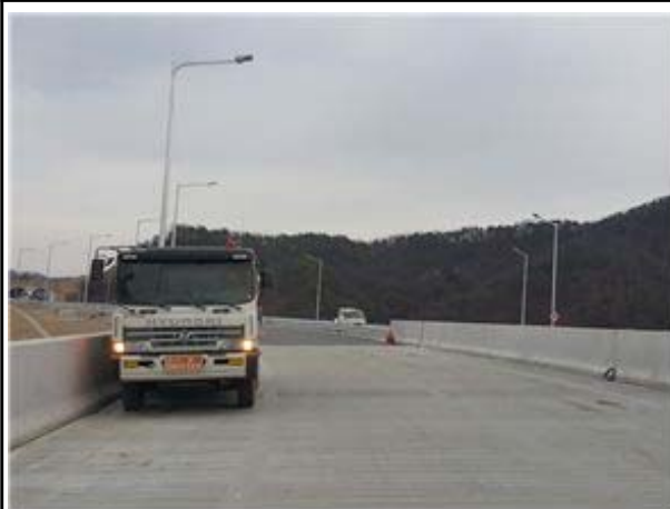
정적 재하시험 전경
