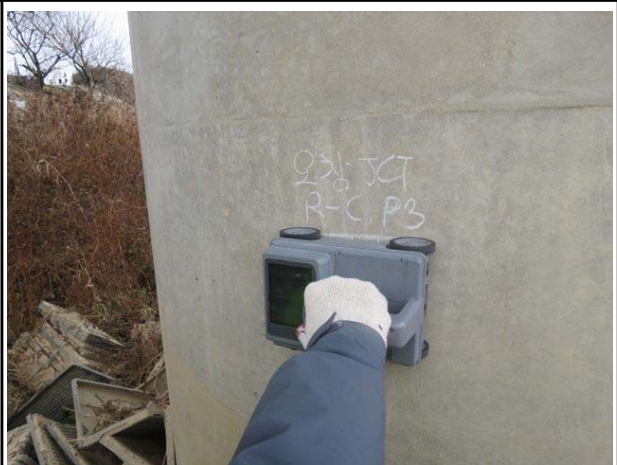
철근배근탐사 시험 전경
