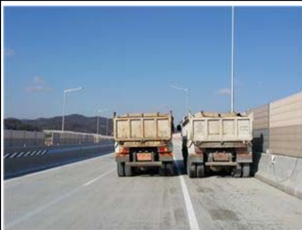
정적 재하시험 전경
