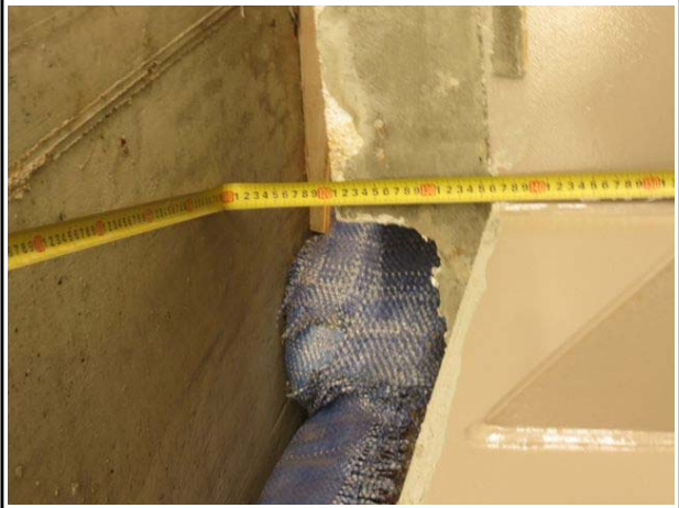
슬래브 유간거리 측정전경
