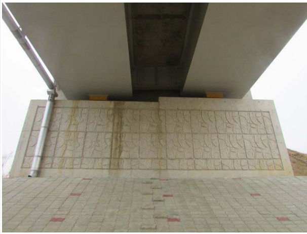
교대 A1 전경
