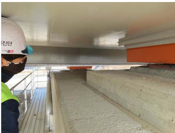
교량받침 연단거리 측정전경
