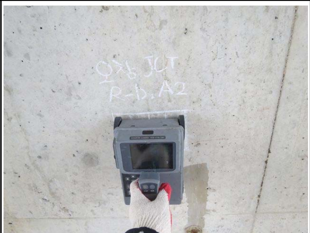
철근배근탐사 시험 전경
