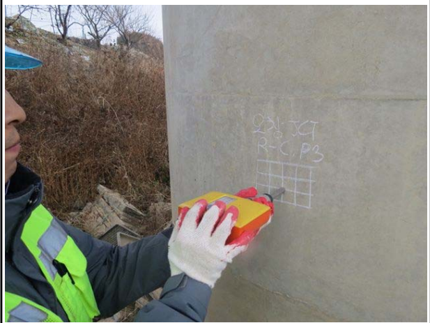
반발경도측정 시험 전경
