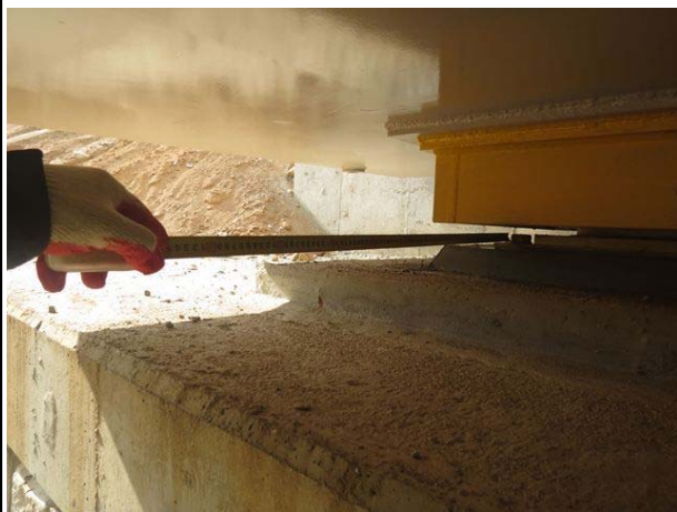
교량받침 연단거리 측정전경
