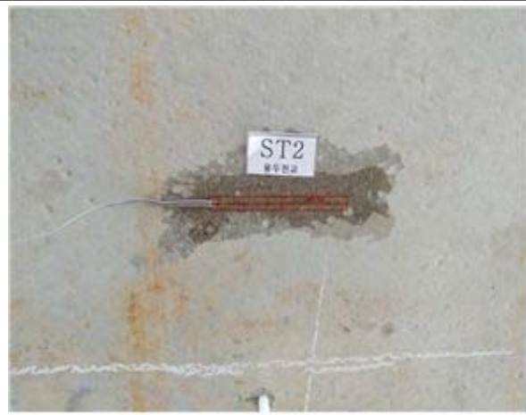
변형률계 설치 현황
