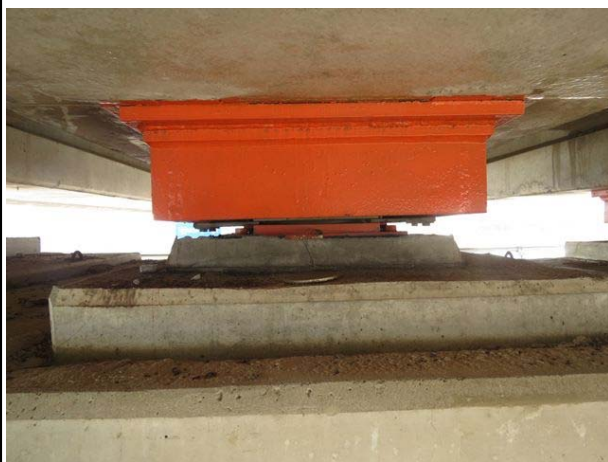
교량받침 상태 양호
