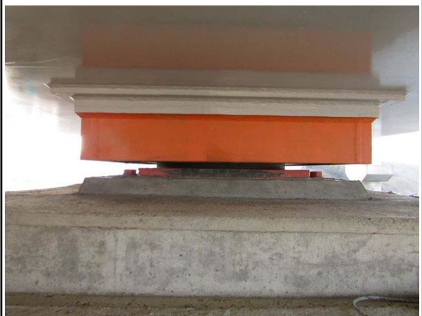
교량받침 상태 양호
