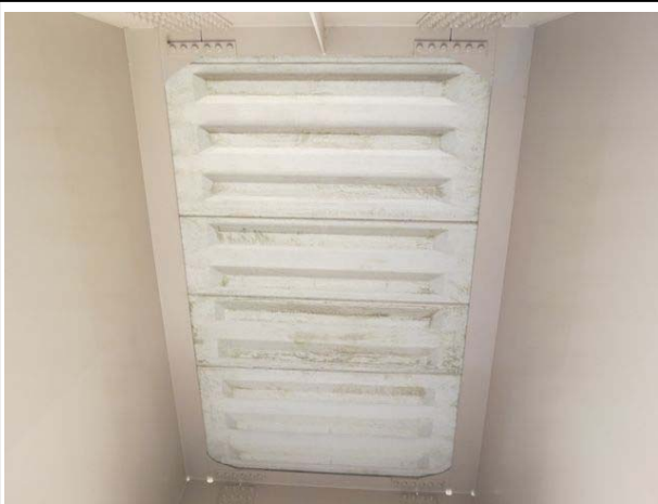
바닥판 중앙부 Rib Deck 상태양호
