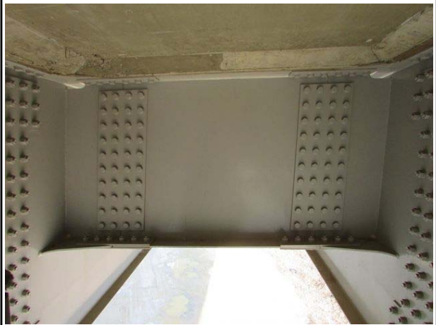
강재 가로보 상태양호
