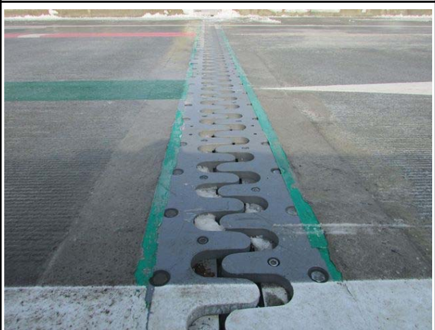
신축이음 상태양호(P3, 옥산방향)
