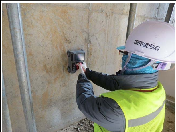
철근배근탐사 시험 전경
