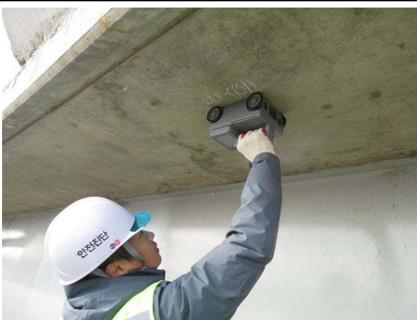
철근배근탐사 시험 전경
