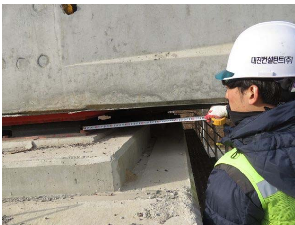
교량받침 연단거리 측정전경
