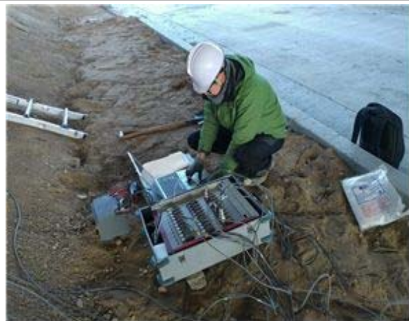
재하시험 계측 전경
