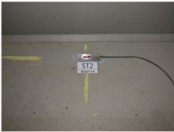
변형률계 설치 현황
