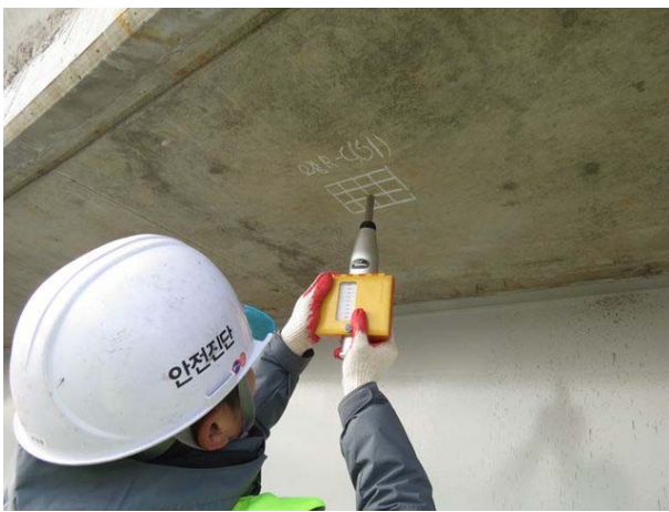
반발경도측정 시험 전경
