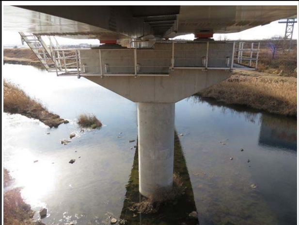
교각 P2 전경
