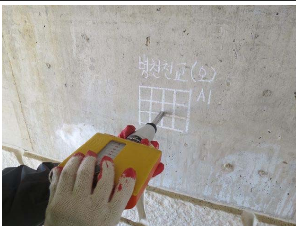
반발경도측정 시험 전경
