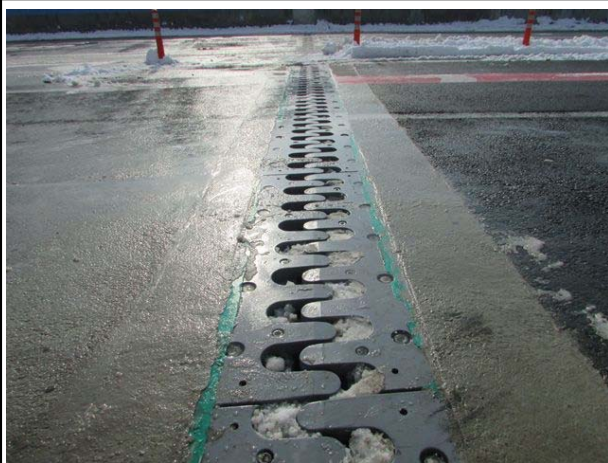
신축이음 상태양호(A1, 옥산방향)
