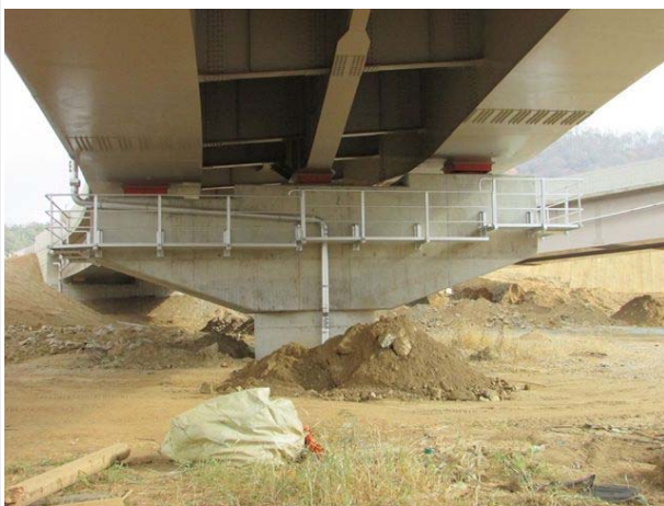
교각 P1 전경
