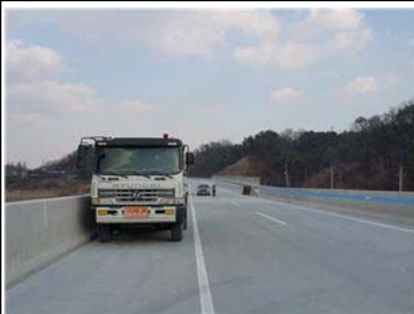
정적 재하시험 전경
