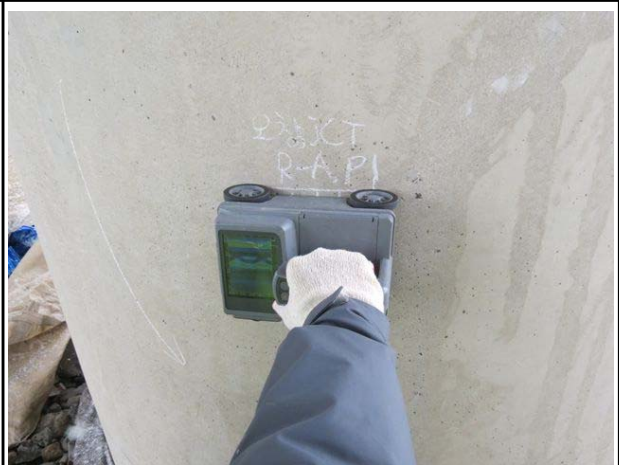
철근배근탐사 시험 전경
