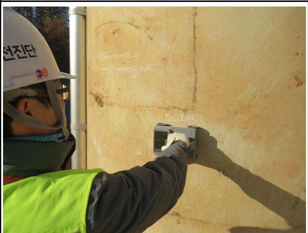
철근배근탐사 시험 전경
