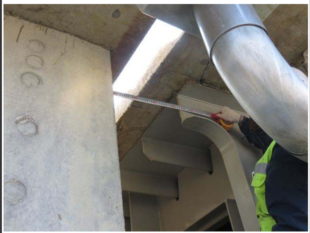
슬래브 유간거리 측정전경
