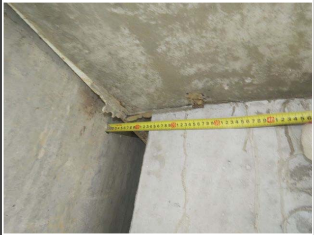
슬래브 유간거리 측정전경
