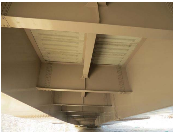
콘크리트 가로보 상태양호
