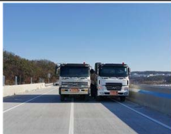
정적 재하시험 전경
