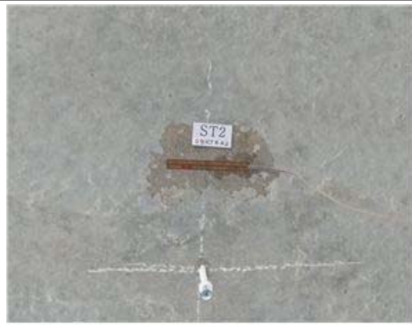
변형률계 설치 현황
