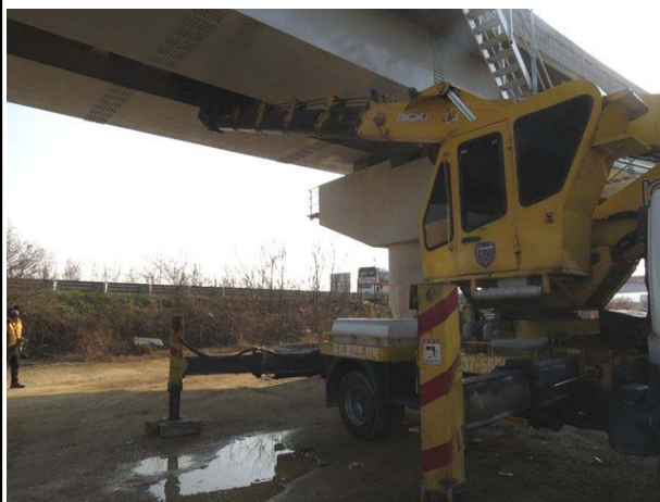
고소점검차를 이용한 바닥판 하부 조사
