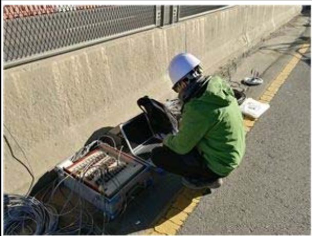
재하시험 계측 전경
