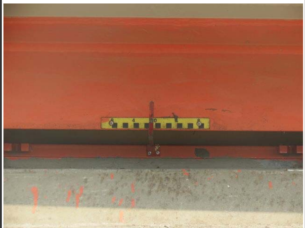
교량받침 이동량 측정전경
