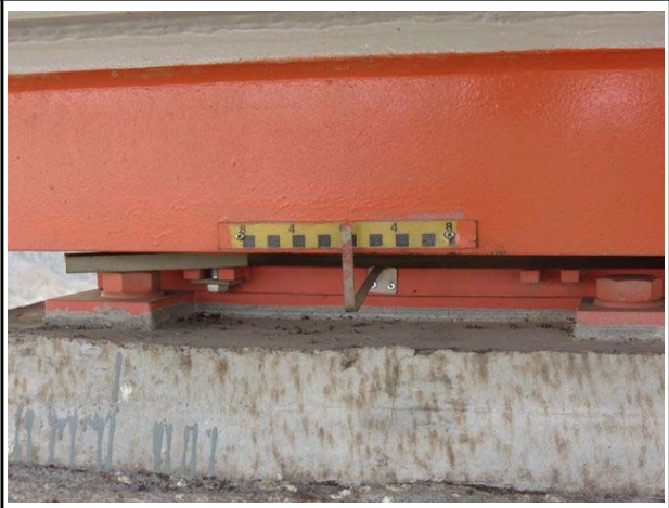
교량받침 이동량 측정전경
