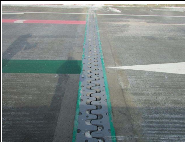
신축이음 상태양호(P3, 옥산방향)
