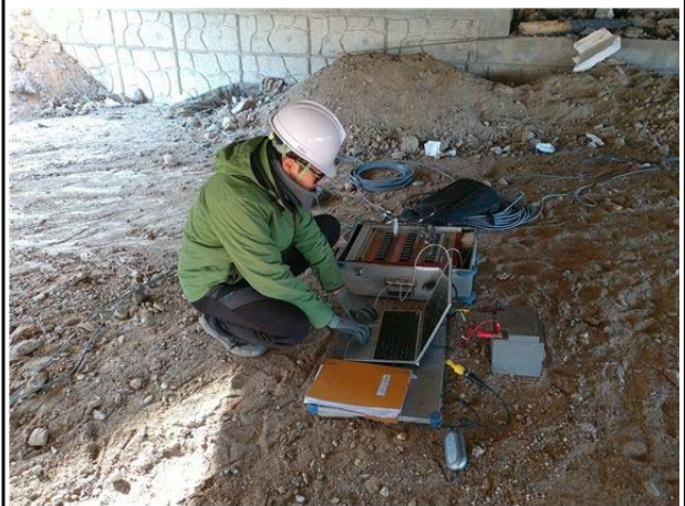
재하시험 계측 전경
