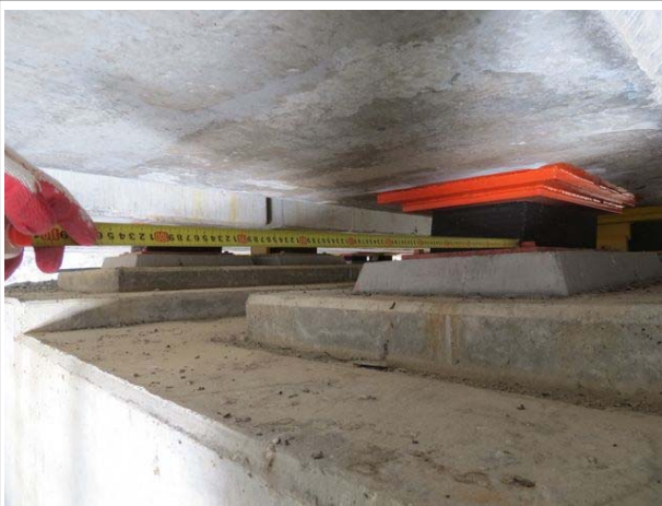
교량받침 연단거리 측정전경
