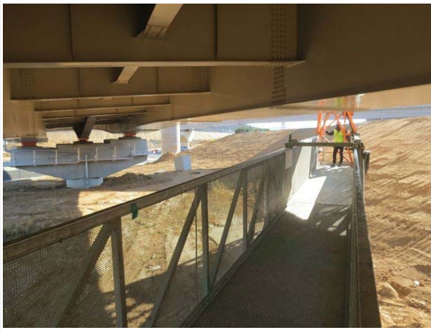
교량점검차를 이용한 바닥판 하부 조사
