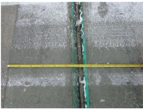
신축 유간거리 측정전경
