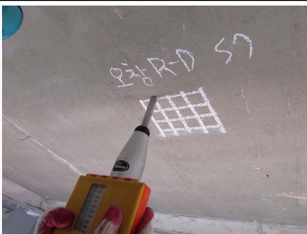
반발경도측정 시험 전경
