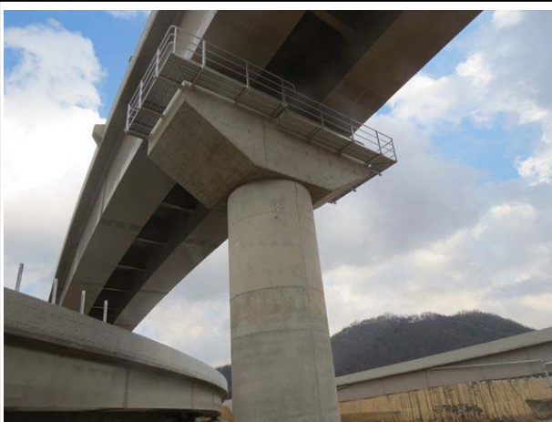
교각 P1 전경
