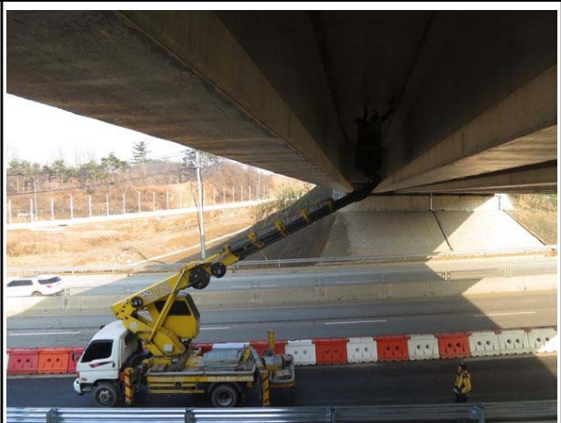
고소점검차를 이용한 바닥판 하부 조사
