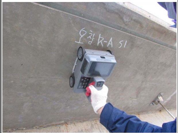
철근배근탐사 시험 전경
