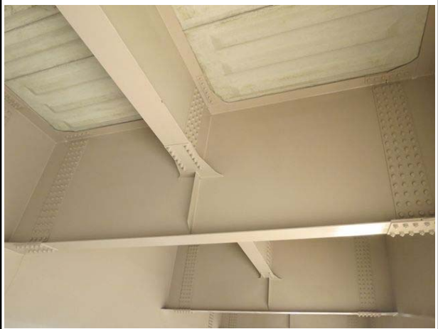
콘크리트 가로보 상태양호
