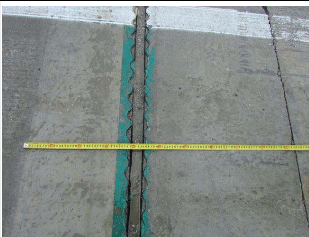
신축 유간거리 측정전경
