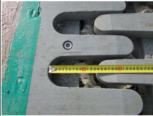
신축 유간거리 측정전경
