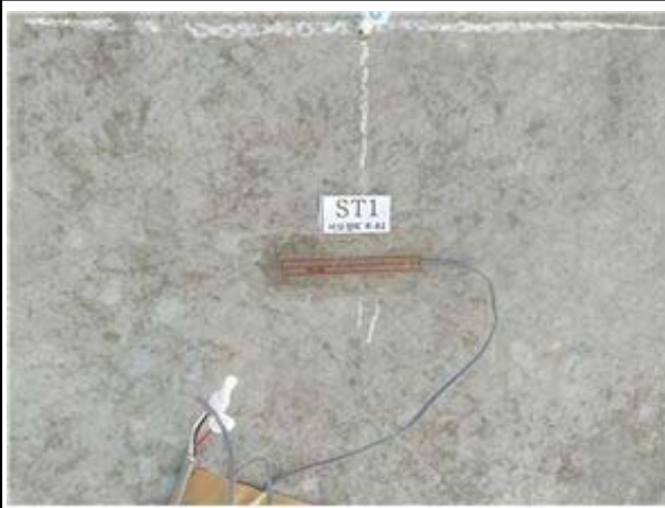
변형률계 설치 현황
