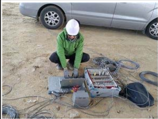
재하시험 계측 전경
