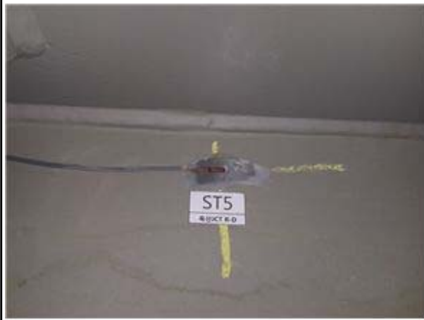
변형률계 설치 현황
