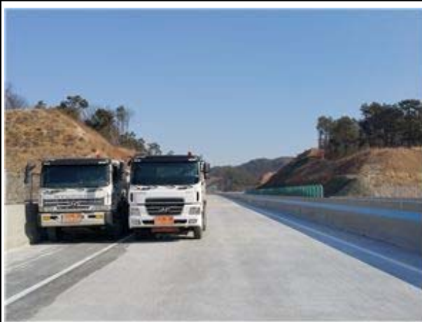
정적 재하시험 전경
