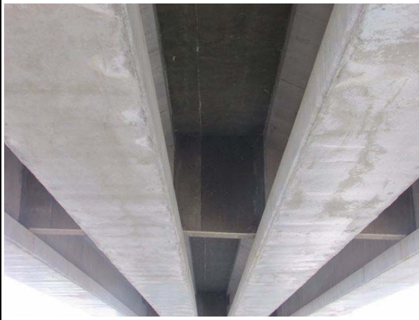
콘크리트 가로보 상태양호
