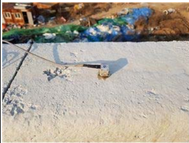
가속도계 설치 현황
