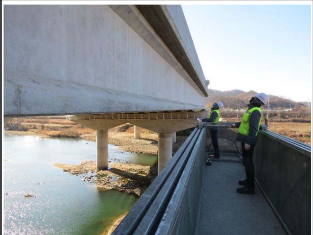
교량점검차를 이용한 바닥판 하부 조사
