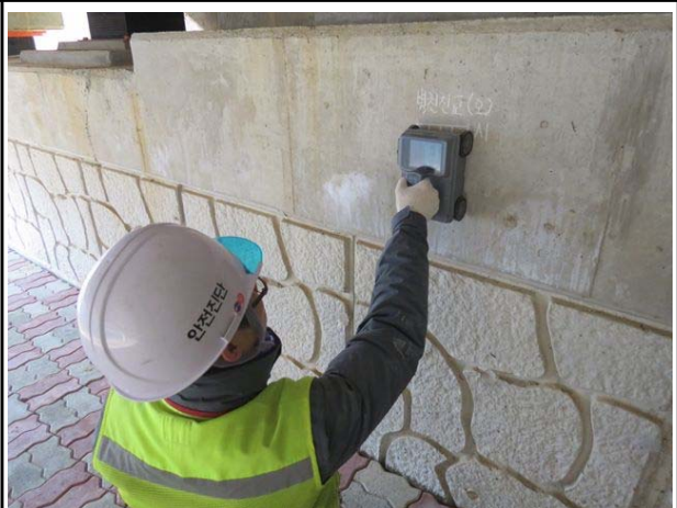
철근배근탐사 시험 전경
