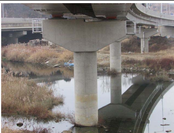
교각 P1 전경
