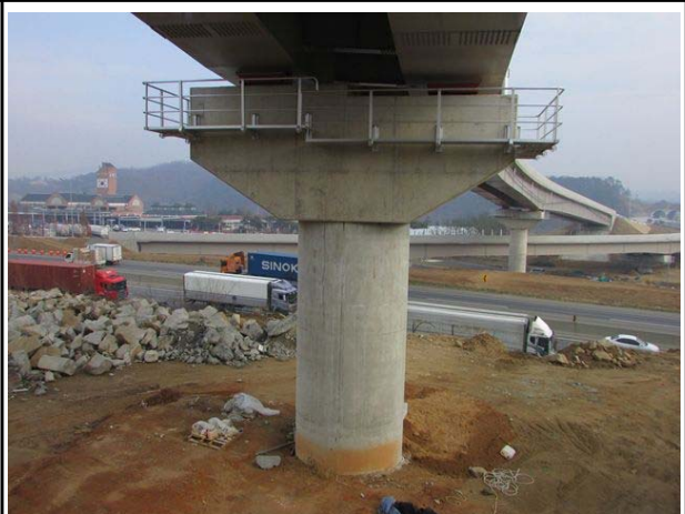
교각 P2 전경
