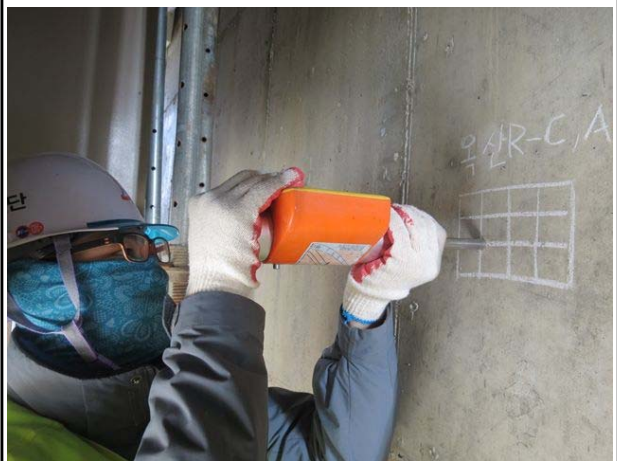
반발경도측정 시험 전경
