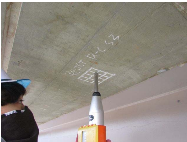
반발경도측정 시험 전경
