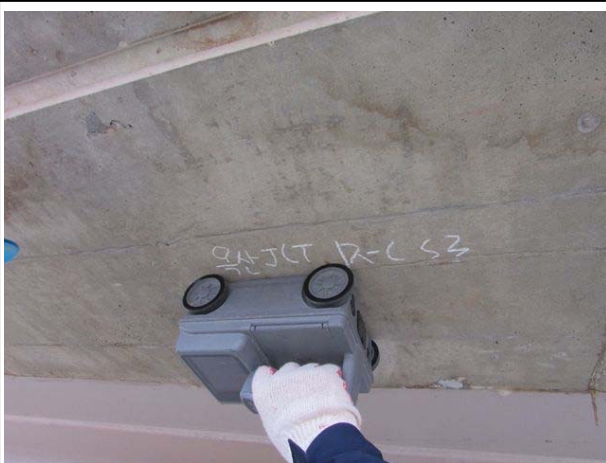
철근배근탐사 시험 전경
