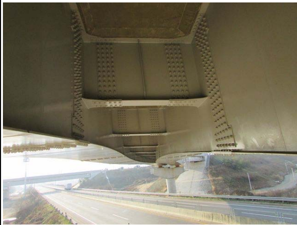
강재 가로보 상태양호
