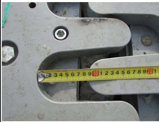
신축 유간거리 측정전경
