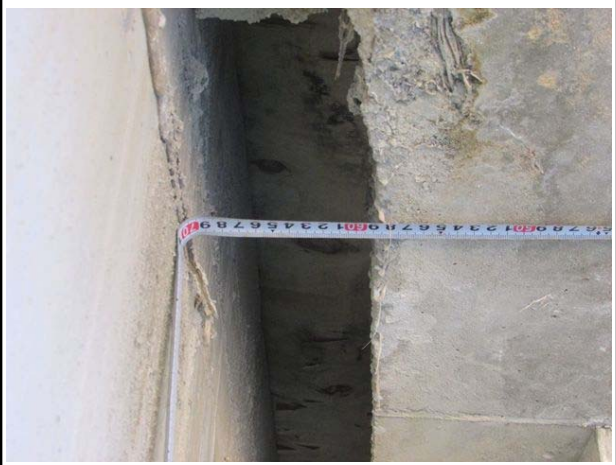
슬래브 유간거리 측정전경
