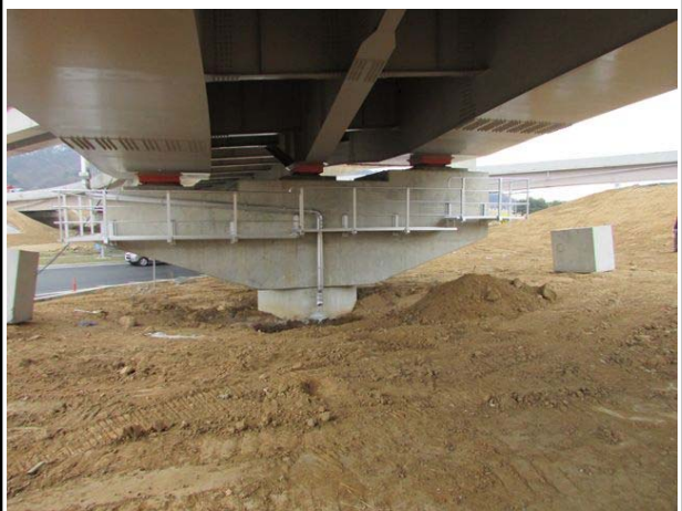
교각 P2 전경
