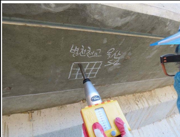
반발경도측정 시험 전경
