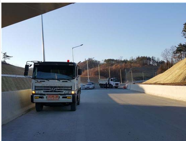
정적 재하시험 전경
