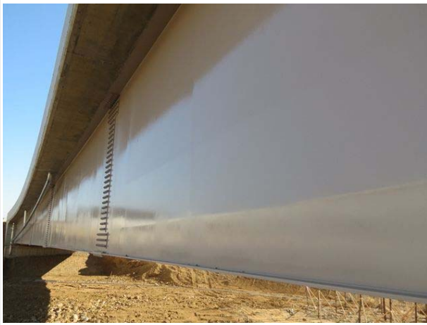
강제 거더 외부 상태양호
