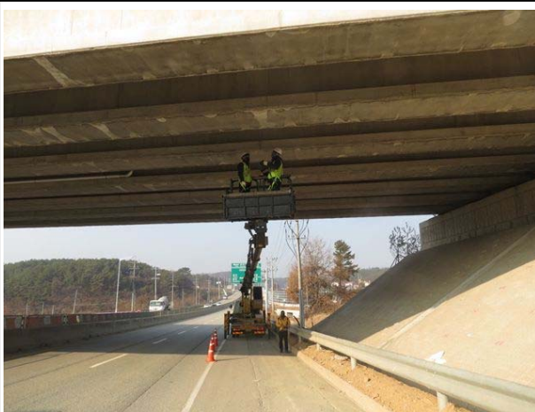
고소점검차를 이용한 바닥판 하부 조사
