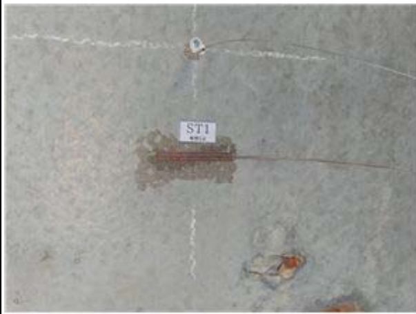
변형률계 설치 현황
