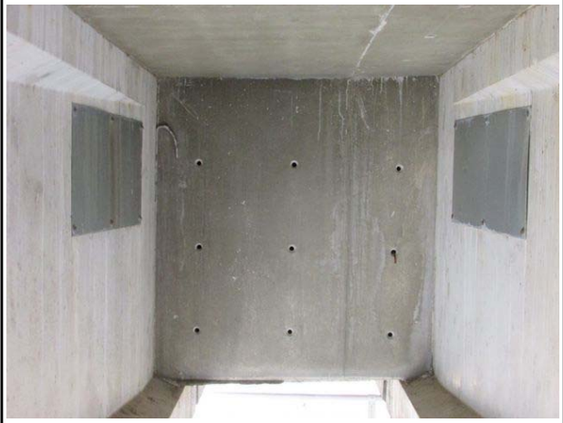
콘크리트 가로보 상태양호
