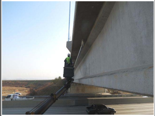
고소점검차를 이용한 바닥판 하부 조사
