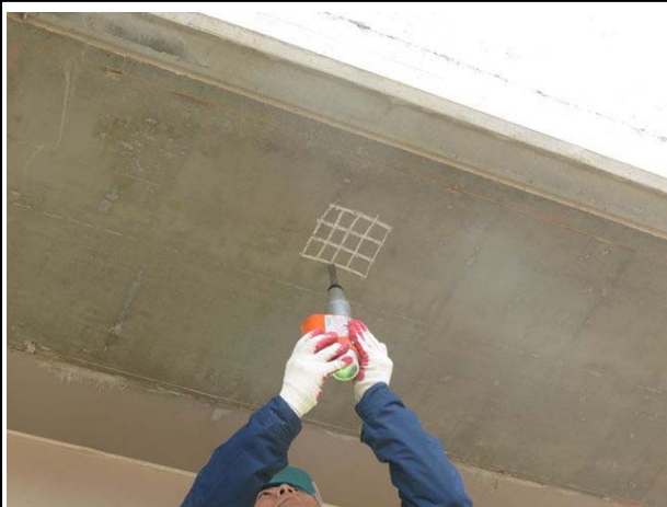
반발경도측정 시험 전경
