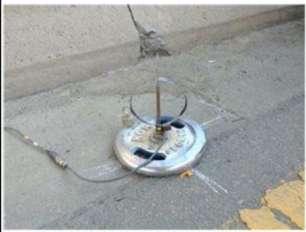
처짐계 설치 현황
