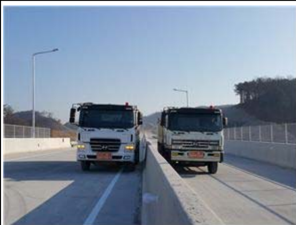
정적 재하시험 전경
