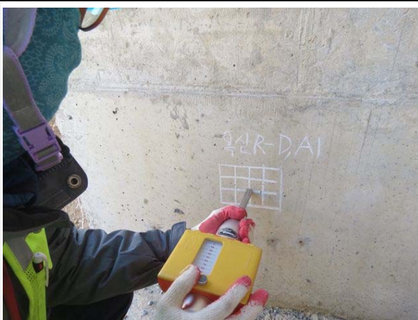
반발경도측정 시험 전경
