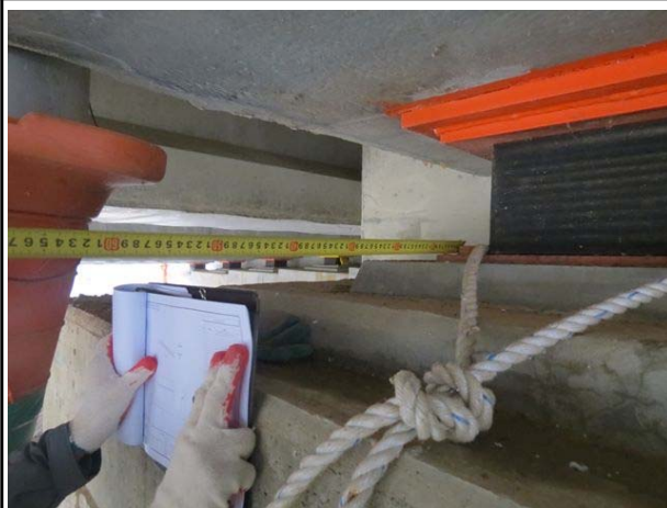
교량받침 연단거리 측정전경
